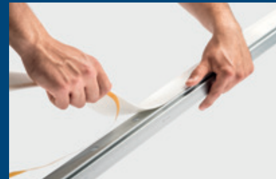
↑ Geberit Duofix süsteemi siinide kinnitamine põranda ja lae külge. Paigaldage Geberit Duofix heliisolatsiooniteip ja kinnitage süsteemi siinid põranda ja lae külge.
