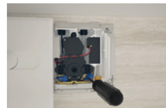
← Eraldiseisev juhtkilp paikneb lihtsasti juurdepääsetavas kohas kraanikausi all. See sisaldab kõiki tehnilisi komponente peale infrapunaanduri ja seda on väga lihtne hooldada.
