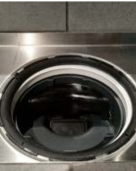
Pärast puhastamist asetatakse vesilukk tagasi.
