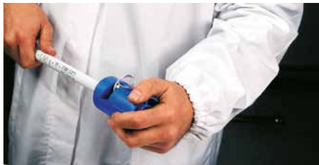
Joonis 29 – Ümbrise eemaldamine (PP kattega steelPRES )
