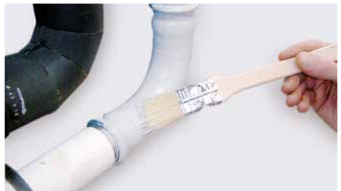
Joonis 34 – Ühenduste ja torude vööpamine kruntvärviga.
