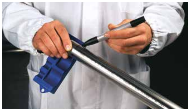
Joonis 28 – Sisestussügavuse märkimine
